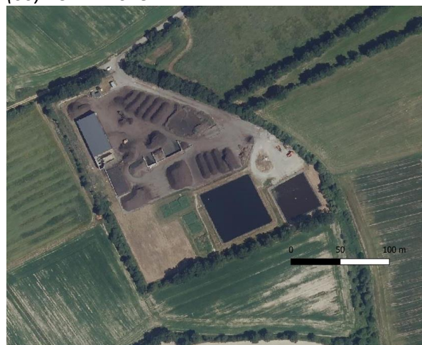
Vue Géoportail du site de Vallet-Fertiloire (44) - Installation de compostage - 2018
