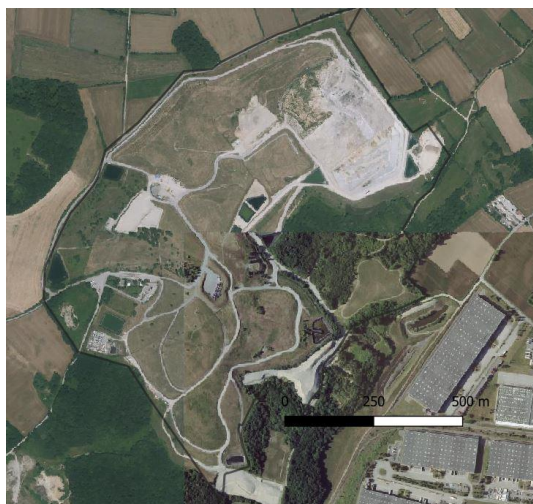
Vue Géoportail du site de Satolas (38) - ISDND - 2018
