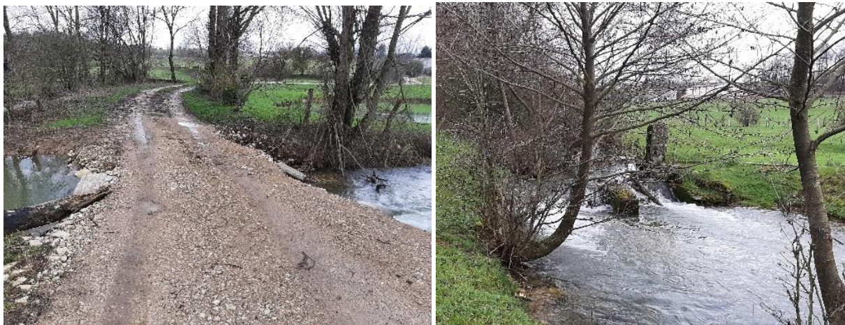
Figure 69 : Buse OU12 à aménager et seuil OU13 à supprimer, Les-Hauts-de-Chée_17/03/2021 (Source : IRH)
