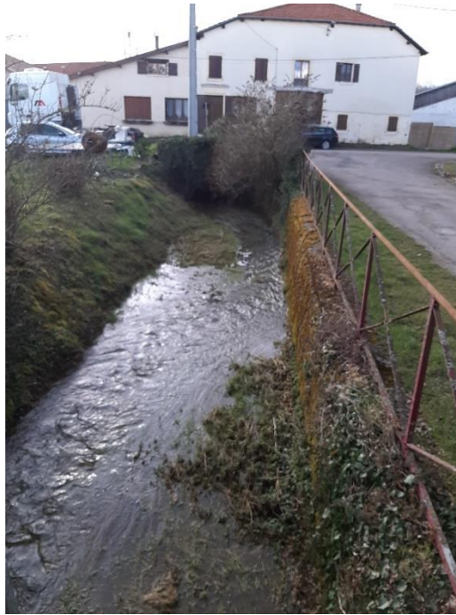
Figure 66 : Banquettes en traversée urbaine de Seigneulles, Seigneulles_17/03/2021 (Source : IRH)
