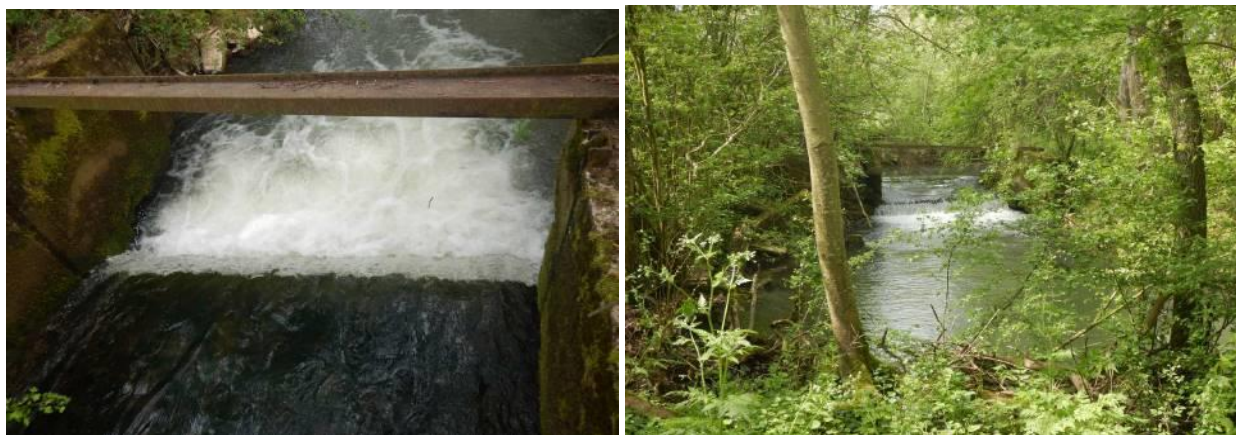
Figure 29 : Photos de l'ouvrage OU12 sur le tronçon n°4 de la Wiseppe (Source : IRH)
