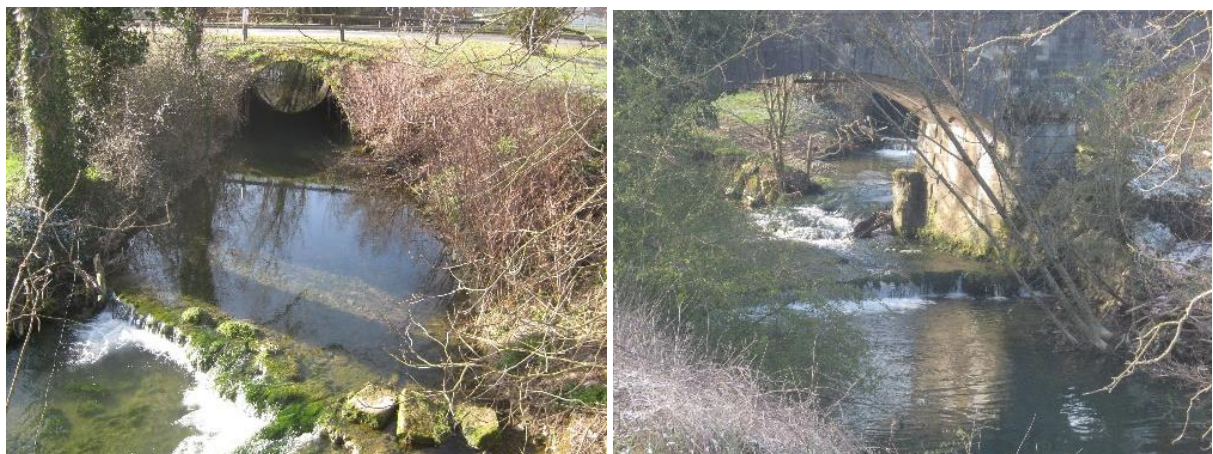
Figure 78 : Seuil OU14 à gauche et radier OU15 à droite, Les-Hauts-de-Chée_07/04/2021
