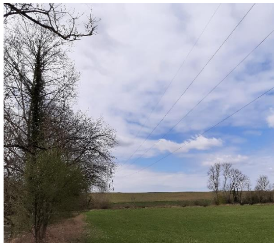
Figure 87 : Ligne électrique sur le tronçon CHE-CP-02, Louppy-le-Château_07/04/2021 (Source : IRH)
