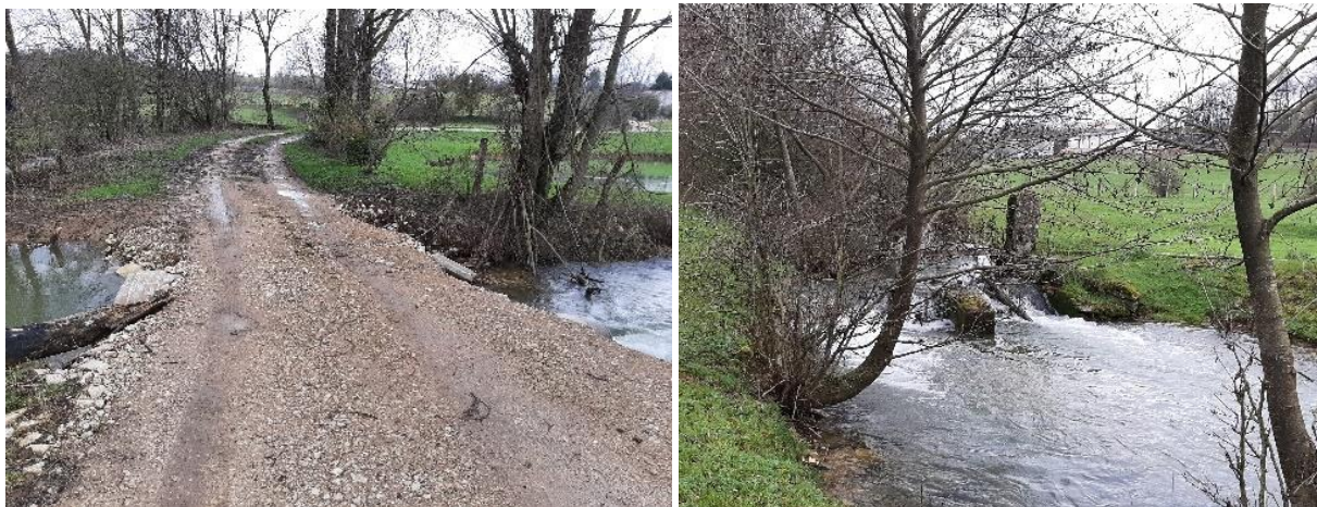
Figure 69 : Buse OU12 à aménager et seuil OU13 à supprimer, Les-Hauts-de-Chée_17/03/2021 (Source : IRH)
