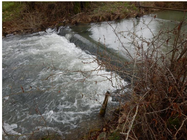
Figure 55 : Seuil OU7, Les-Hauts-de-Chée_17/03/2021 (Source : IRH)
