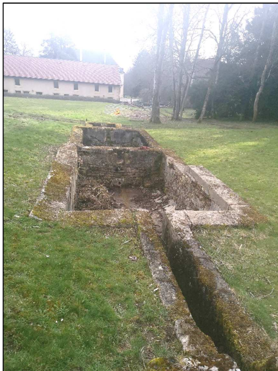
Figure 11 : Bassins piscicoles avant travaux (Source : BEPG)
