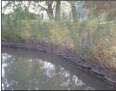
Figure 7 : Fascine de saule
