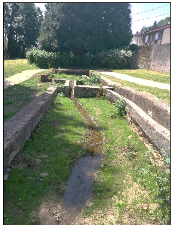
Figure 10 : Bassins piscicoles après travaux (Source : BEPG)
