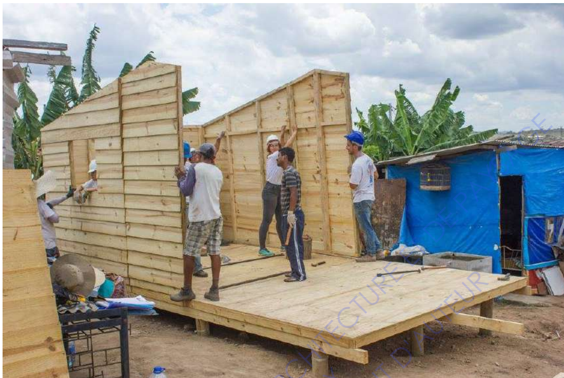
Fig 18: Mise en place des pans de murs longitudinaux
