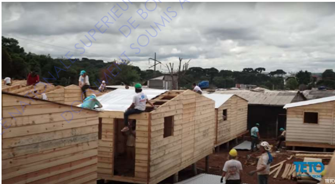
Fig 21: Mise en place de l'étanchéité de toiture
