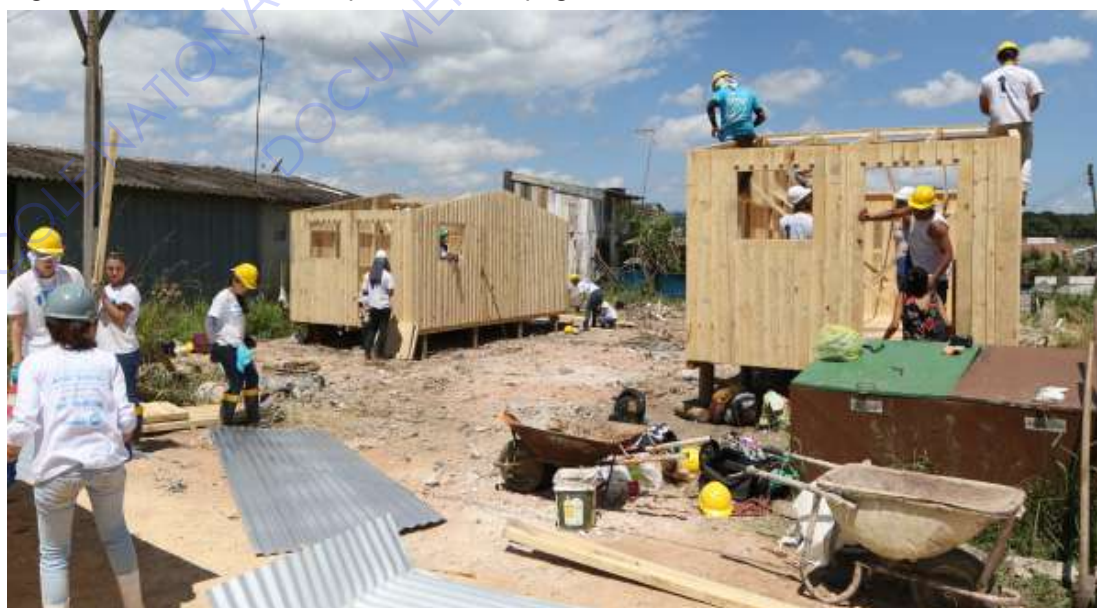
Fig 20: Installation de la charpente et découpage de la tôle
