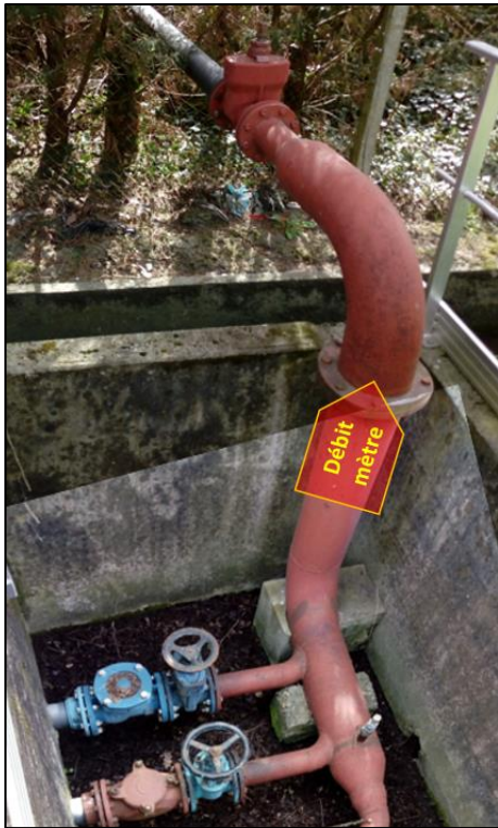
Pose du débitmètre à la verticale
