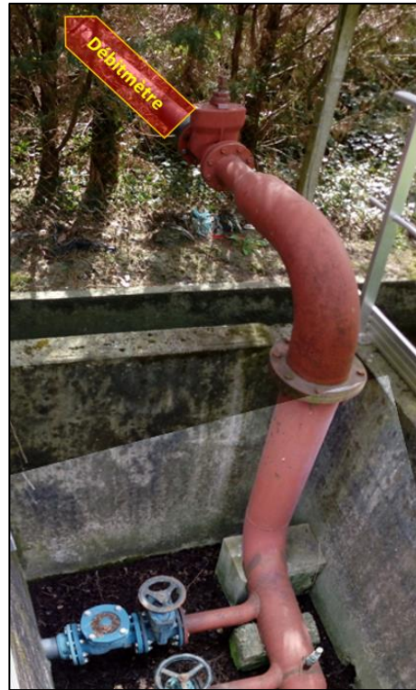
Pose du débitmètre l'horizontale
