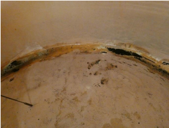
Fond de cuve
