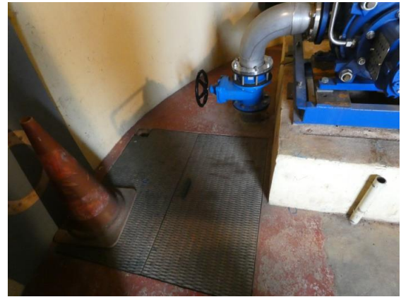
Trappe d'accès à la galerie technique – P0
