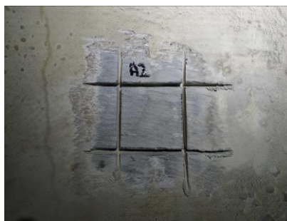
Préparation du support par meulage
