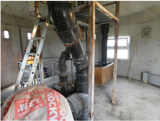
Canalisations calorifugées, état non vérifiable
