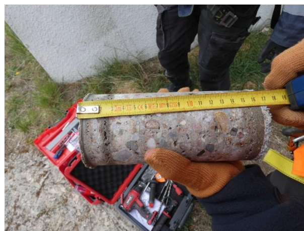
Figure 16 : Prélèvement par carottage dans la tour du réservoir de Bois Bourgeot
