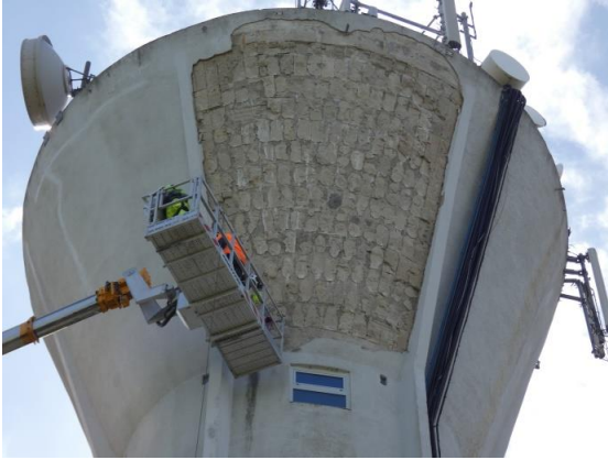
Voile cuve extérieur orienté nord-ouest
