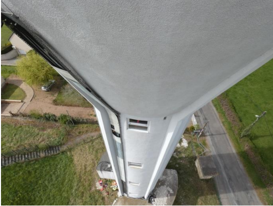
Vue de la parcelle depuis la nacelle
