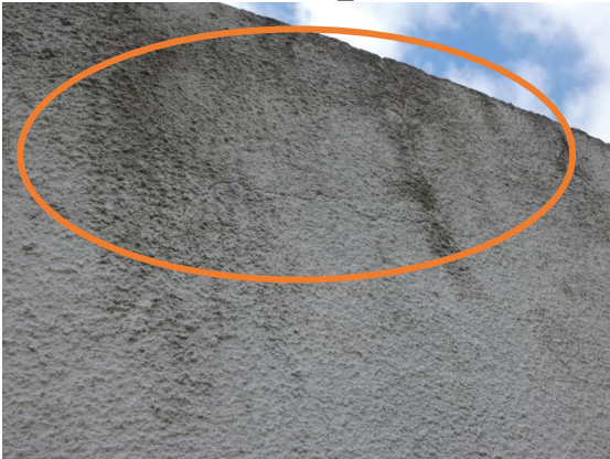
Faiçonnage de l'enduit de l'acrotère (Fext_5) – voile nord
