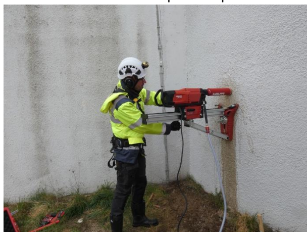
Figure 15 : Réalisation d'un carottage dans la tour du réservoir de Bois Bourgeot
