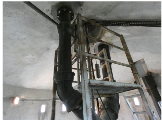
Accès cheminée centrale – P4
