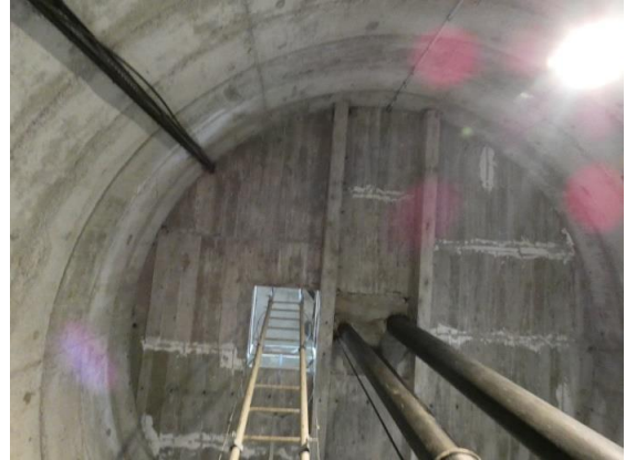
Accès palier P4
