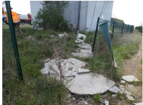
Vue de la clôture extérieure à l'angle nord-ouest
