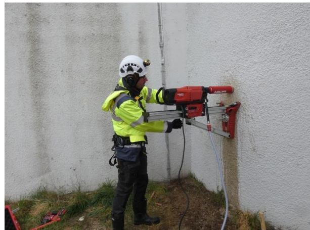
Carottage de l'ouvrage
