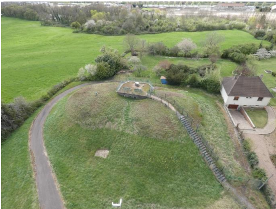
Vue de la parcelle et du réservoir semi-enterré depuis la nacelle
