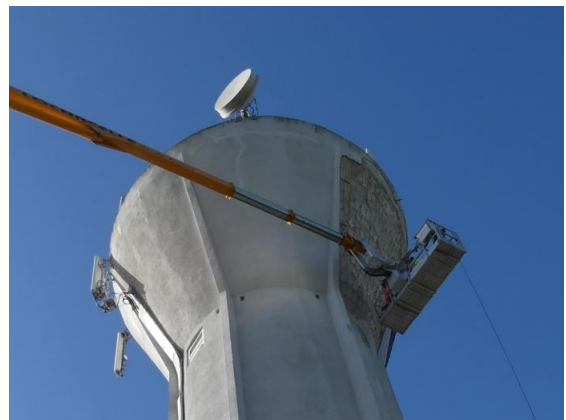
Voile cuve extérieur orienté nord-est
