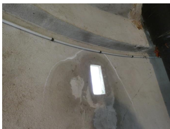
Epanchement de calcite (Fint_7) – P4
