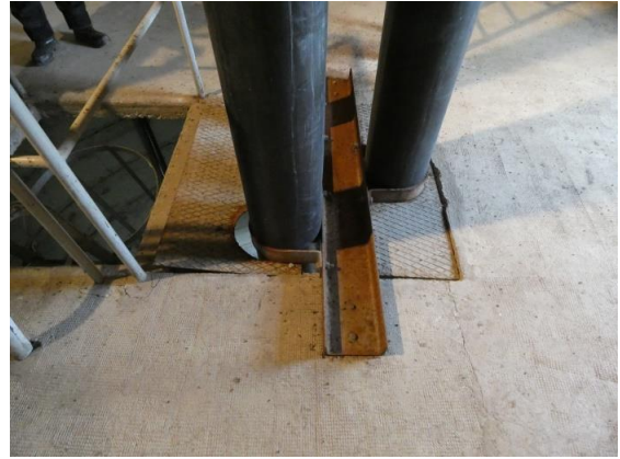
Canalisations calorifugées, état non vérifiable
