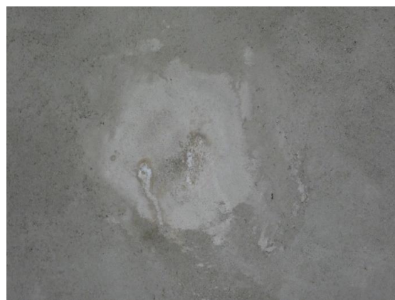
Epanchement de calcite (Fint_5) – intrados fond de cuve
