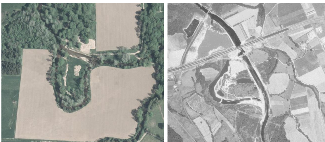
FIGURE 13 : PHOTOGRAPHIES AERIENNES DE RECTIFICATION DE MEANDRES (AMBERT A GAUCHE ET THIERS A DROITE)
