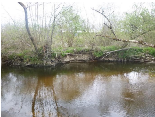
Encoche d'érosion menaçant la capture d'une autre gravière plus à l'aval
