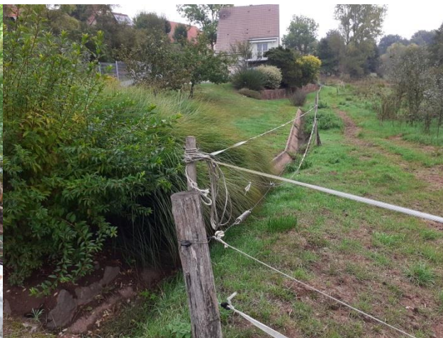
Figure 11 : Canal d'aménagé du Moulin
