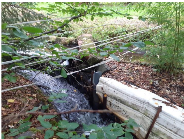
Figure 110 : Déversoir du Mittelbach
