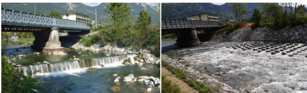
Figure 27 : Photographie avant/après de la rampe à enrochements régulièrement répartis de Marignier sur la Griffie (75)
