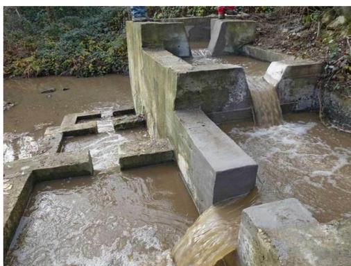
Figure 19 : Passe à "jet plongeant" sur le ruisseau du Fondagny (69)
