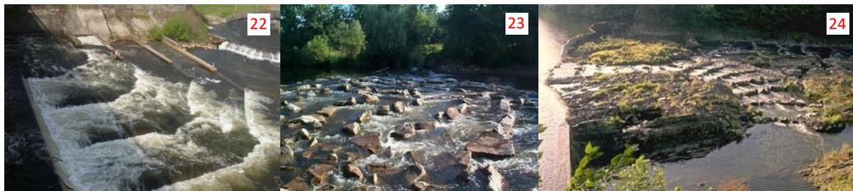
Figure 22 : Passe à poissons de type pré-barrages située au pont du barrage de Vichy (03)
