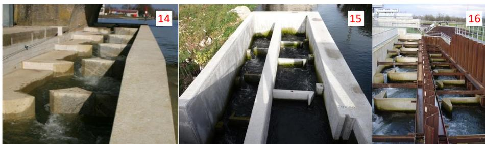
Figure 14 : Passe à poissons du barrage de Gray (70)
