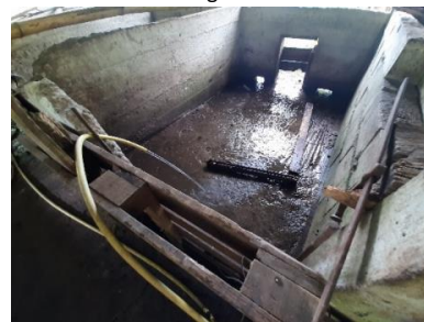
Parc en béton pendant arrosage
