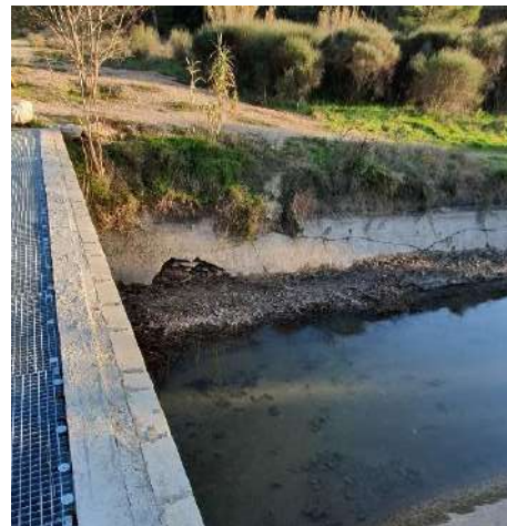
d) Revêtement en béton – Moyen (PM-16807)
