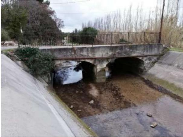
Pont en maçonnerie avec pile centrale (OF-8441)
