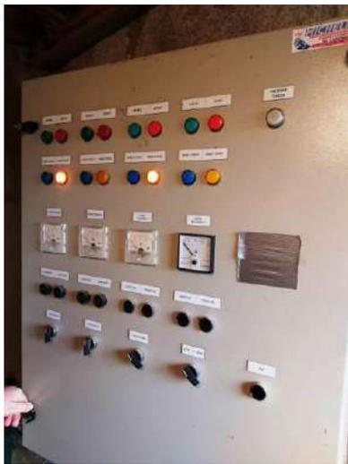
c) Face avant armoire contrôle commande
