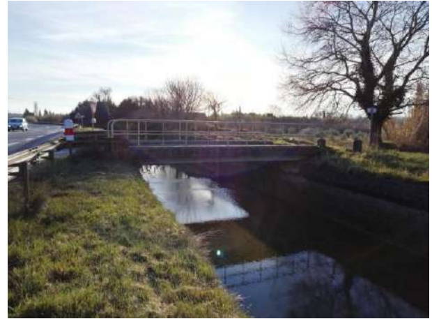
Pont-dalle sans pile centrale (tablier sous la berge du canal) (OF-3761)
