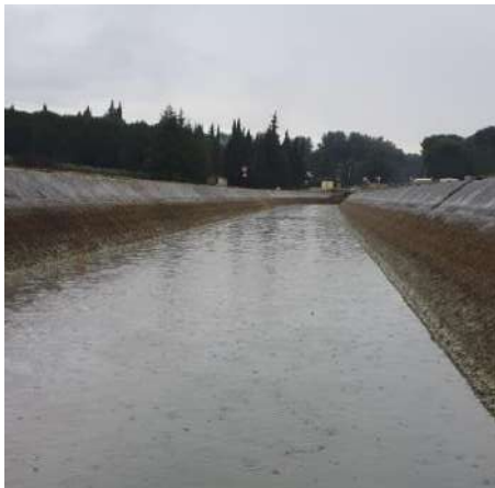
a) Revêtement en béton - bon état (PM-15090)
