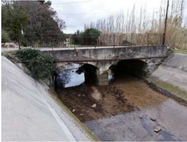
Pont en maçonnerie avec pile centrale (OF-8441)
