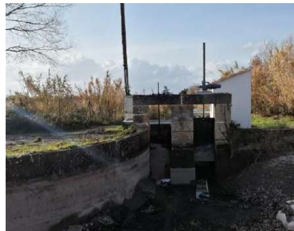
d) Prise du canal de l'Isle - Tour de Sabran PR-22401
