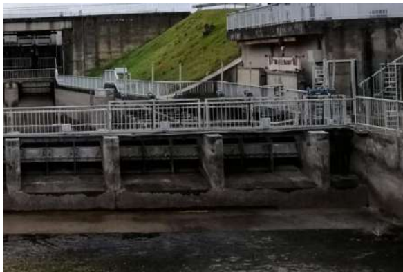
Figure 3-2 : Ouvrage de prise en tête - Module à Masque type C1 (PM-0)
