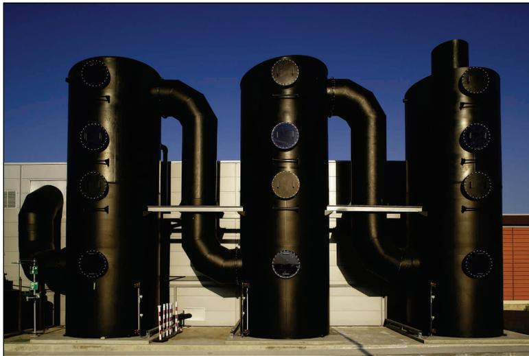
Figure 9: Exemple de la désodorisation physico-chimique avec 1 tour pH acide et 2 tours pH basique. [VEOLIA]
