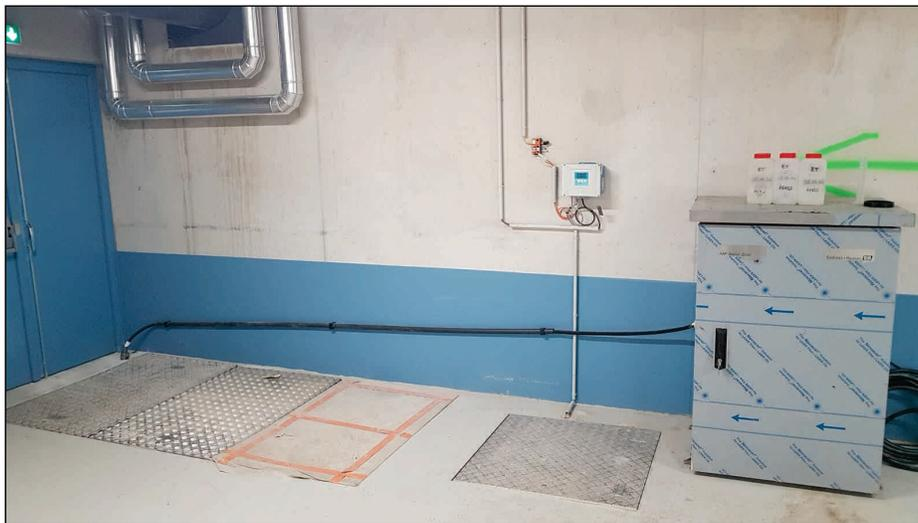
Figure 18: Positionnement du préleveur d'eau traitée de l'Usine de Cagnes-sur-Mer. [Alexis Larcade]
