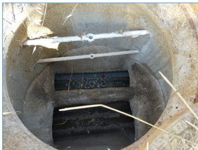
Figure 13: Exemple d'un regard mixte EU et EP
