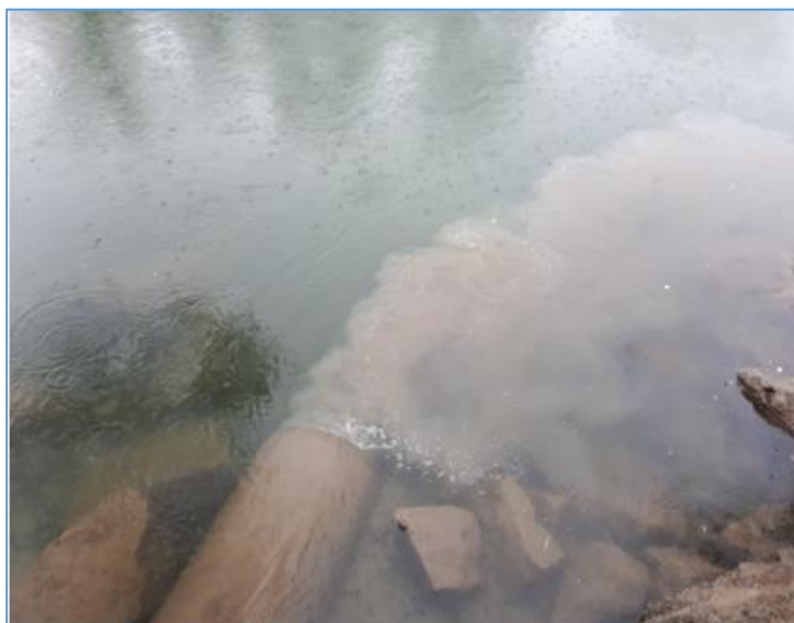
Figure 16: Déversement au niveau du DO Richard II
