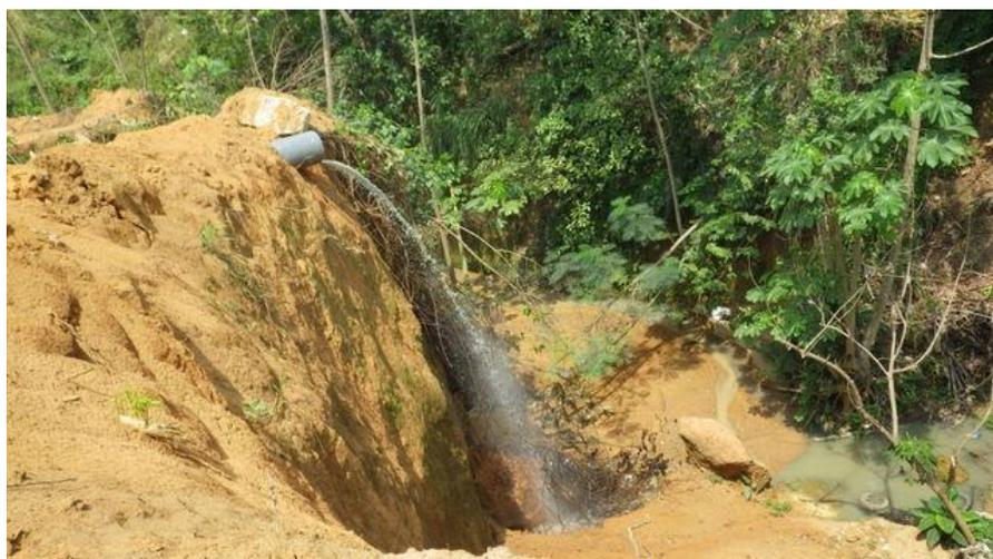
Figure 9 : Rejet direct des eaux collectées par un réseau d'assainissement dans le milieu naturel (cours d'eau)
