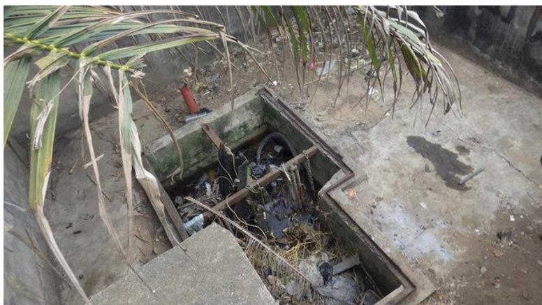
*Figure 20 : Poste de refoulement hors service*
