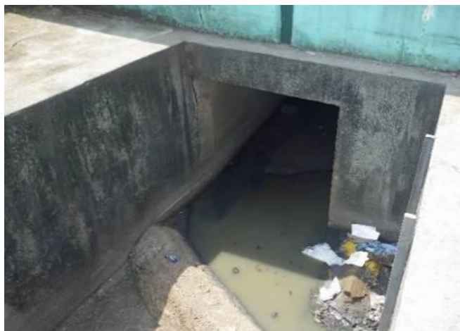
Figure 19 : Déversoir d'orage
