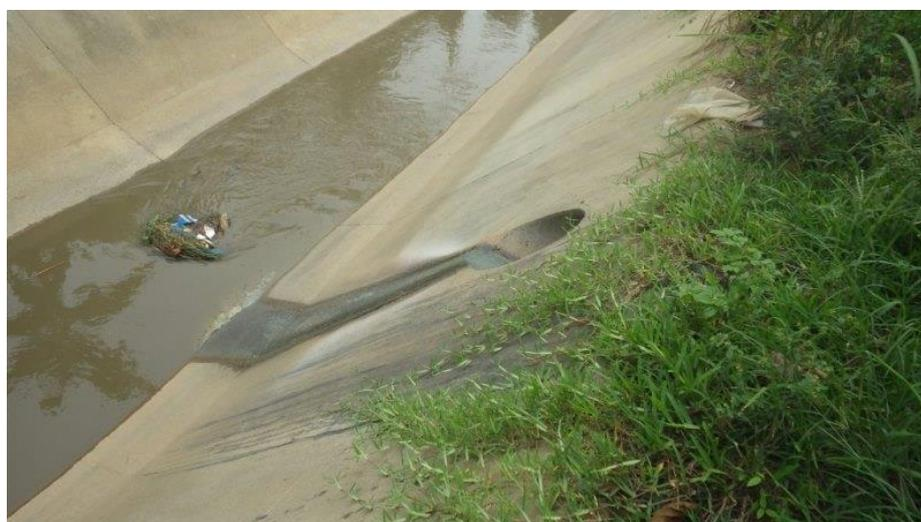
Figure 10 : Photo de l'exutoire d'un réseau d'assainissement : les eaux usées sont rejetées directement dans un canal pluvial
