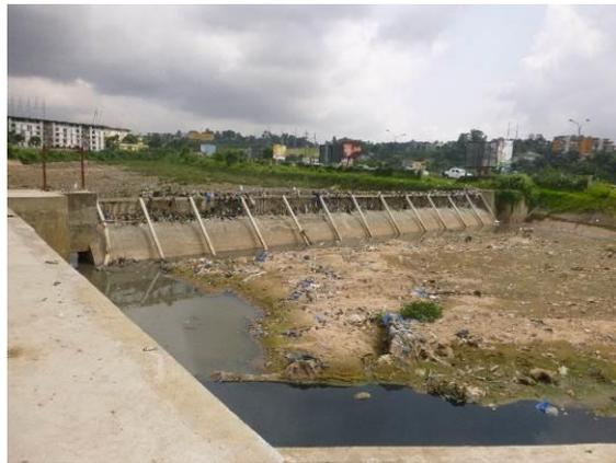
*Figure 7 : Bassin de décantation équipé d'un dégrilleur à l'aval du canal du Gourou*
