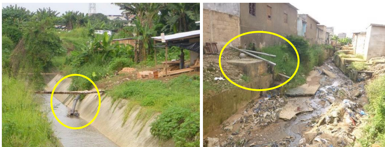
Figure 11 : Exemples de rejets directs des eaux usées des habitations
