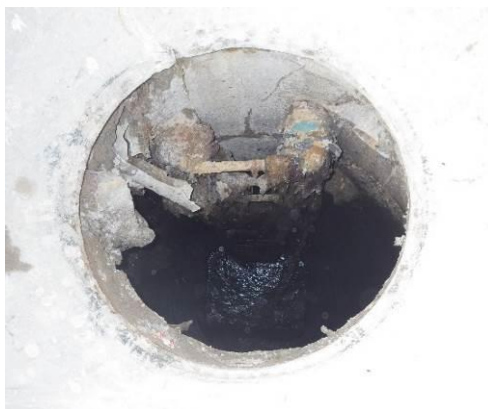
Figure 15 : Traces de mises en charges des regards
