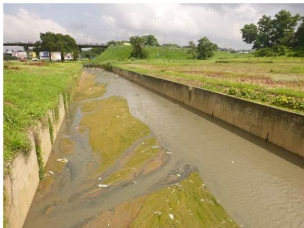
Figure 12 : Ecoulements d'eaux usées dans le canal principal du Gourou par temps sec
