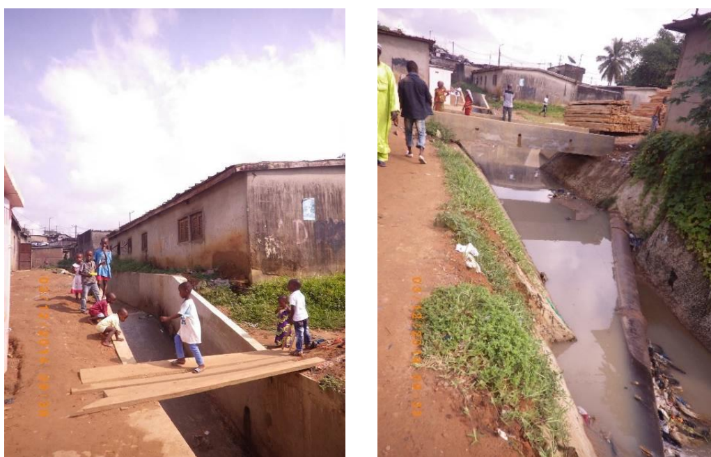
Figure 13 : gauche : Enfants jouant près d'un canal pluvial transportant des eaux usées droite : Ecoulement d'eaux usées dans un canal. Noter la présence d'une canalisation d'eau potable en traversée du canal : impact sanitaire potentiellement important en cas de casse
