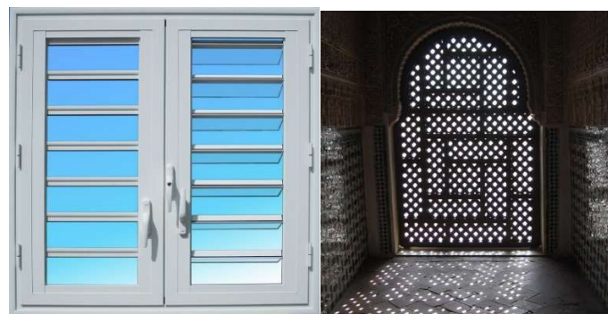
Figure 16 - illustration d'une jalousie et d'un moucharabieh, source : recherche internet
