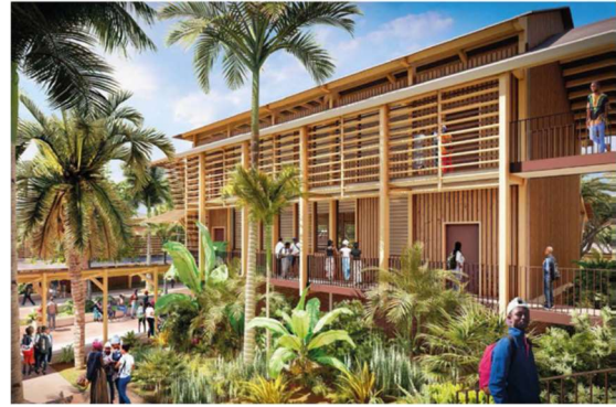
Figure 21 - photos à gauche : bâtiment construit par l'architecte Attila Cheyssial à Tsimkoura avec débord de toiture et sur-toiture ventilé. Photo à droite : modélisation du projet de restructuration du collège de Tsimkoura avec des brises soleil à lames horizontales et des coursives extérieurs.
