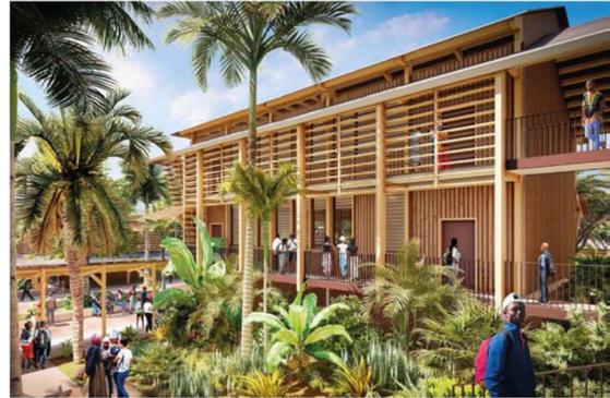
**Figure 21 - photos à gauche : bâtiment construit par l'architecte Attila Cheyssial à Tsimkoura avec débord de toiture et sur-toiture ventilé. Photo à droite : modélisation du projet de restructuration du collège de Tsimkoura avec des brises soleil à lames horizontales et des coursives extérieurs.**
