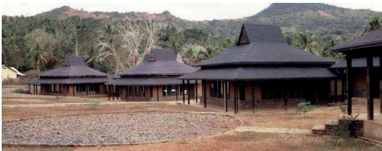
Figure 29 – Photo de la cour actuelle du collège avec la présence des bâtiments d'origine
