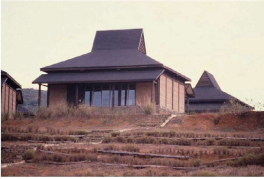
Figure 21 - photos à gauche : bâtiment construit par l'architecte Attila Cheyssial à Tsimkoura avec débord de toiture et sur-toiture ventilé. Photo à droite : modélisation du projet de restructuration du collège de Tsimkoura avec des brises soleil à lames horizontales et des coursives extérieurs.
