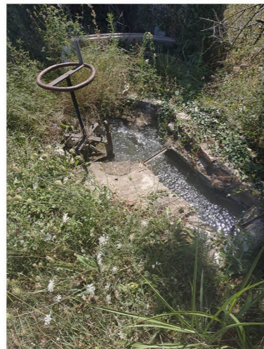
Une martelière ouverte, à gauche et à droite. (Canaux de la plaine d'Avignon, 20/08/2021)
