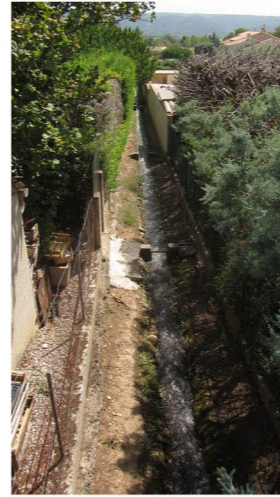
Une filiolle, difficile d'accès entre les habitations à Volx. (Canal de Manosque, 13/08/2021)
