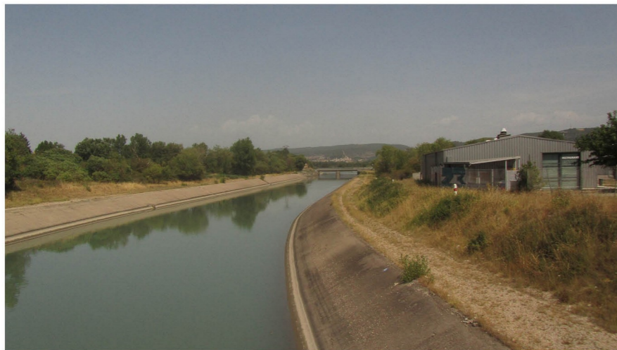
Le canal EDF a profondément changé le paysage de la vallée et bouleversé les usages de l'eau.
