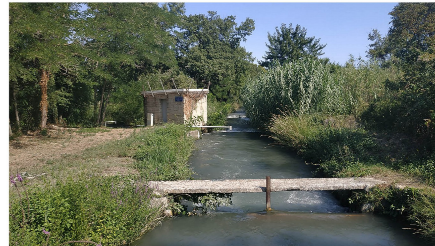
Une ancienne traversée de la Filiolle de Montfavet et le local technique gérant les débits vers les filioles secondaires. (Canaux de la plaine d'Avignon, 20/08/2021).
