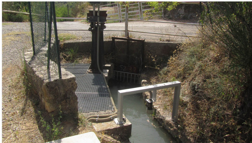
Les martelières peuvent être actionnées automatiquement grâce à un système de détection (arche blanche). (Canal de Manosque, 13/08/2021)
