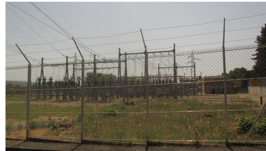
L'eau sert à produire de l'électricité. Usine hydroélectrique de la Brillanne.
