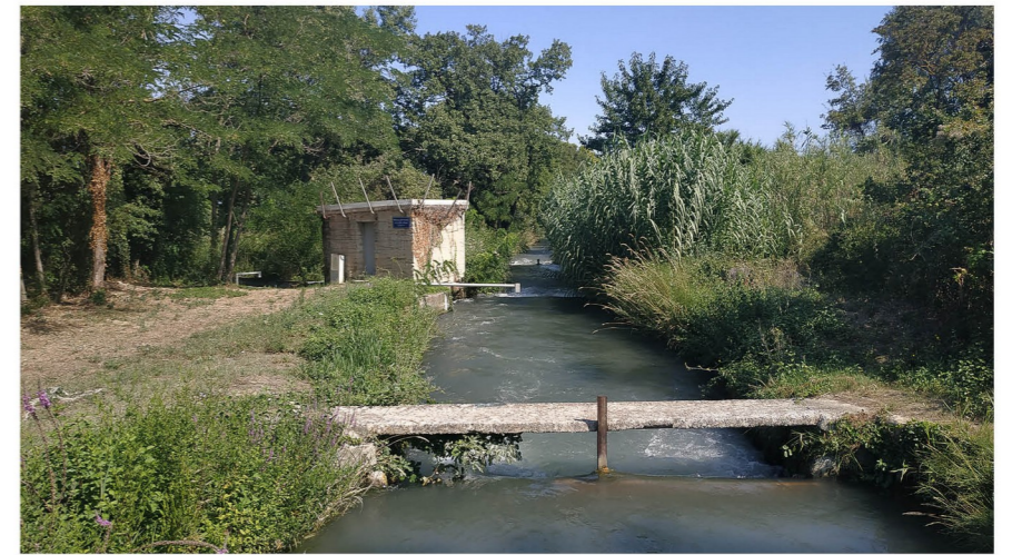
Une ancienne traversée de la Filiolle de Montfavet et le local technique gérant les débits vers les filioles secondaires. (Canaux de la plaine d'Avignon, 20/08/2021).
