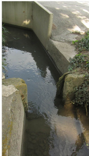
Une martelière ouverte, à gauche et à droite. (Canaux de la plaine d'Avignon, 20/08/2021)
