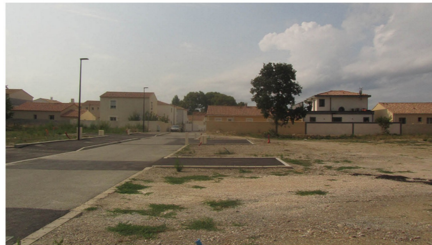
Les opérations d'aménagement sur des parcelles agricoles irriguées. (Canaux de la plaine d'Avignon, 24/08/2021)
