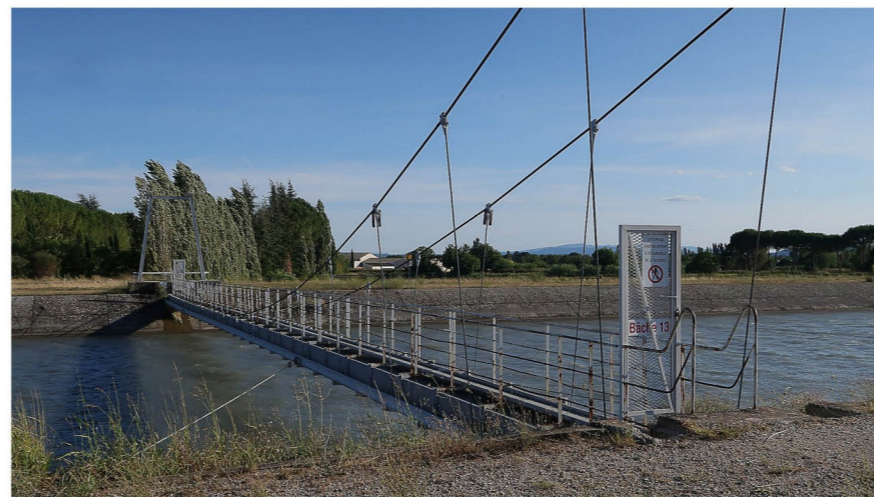
Le canal de la Brillanne traverse le canal EDF à l'aide d'un aqueduc. (Canal de la Brillanne, 05/08/2021)
