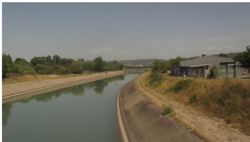
Le canal EDF a profondément changé le paysage de la vallée et bouleversé les usages de l'eau.
