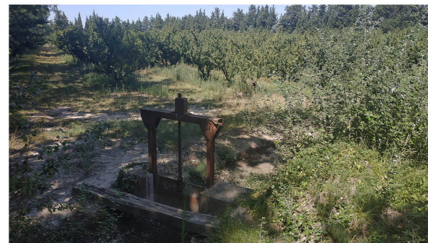
Lorsque l'agriculteur ouvre la martelière, l'eau court dans les rigoles et irrigue la parcelle. (Canaux de la plaine d'Avignon, 20/08/2021)
