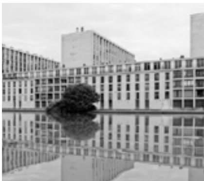
Fig. 56 : Ville Fluctuante, Meudon-La-Forêt, photographie non-sourcée et non datée
