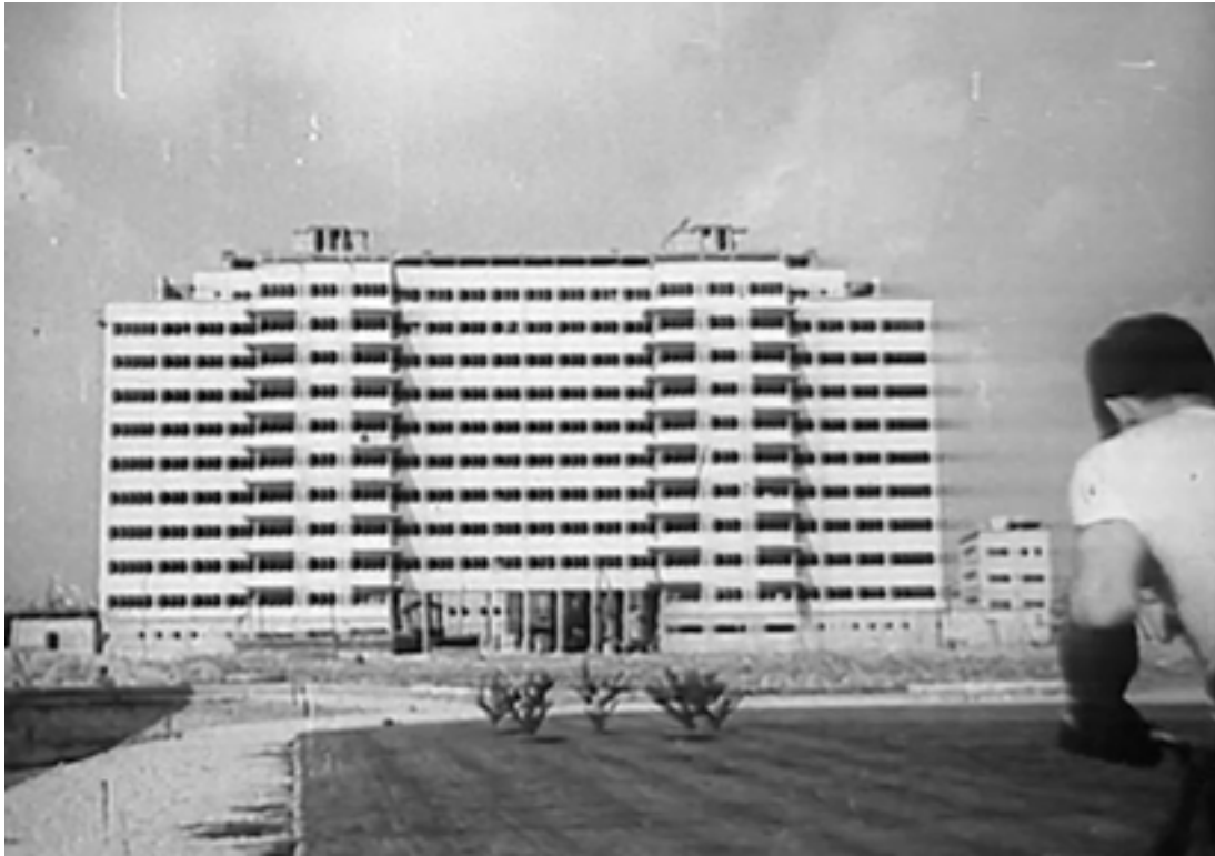
Fig. 6 : Construction de la Cité Benauges, Bordeaux, tiré du documentaire 1956, Naissance d'une cité, Marcel Hubsch, 1956
