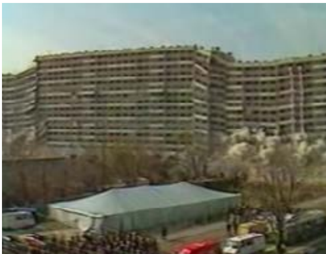
Fig. 57 : Destruction de la Barre Debussy aux 4000, Archives INA, 1986
