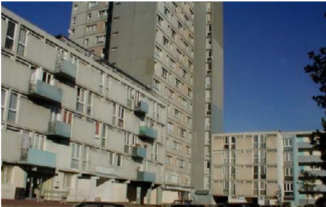
Fig. 54 : La Cité de l’Étoile, Benoit Pouvreau pour l’Atlas de l’architecture et du patrimoine de la Seine Saint Denis, 2004
