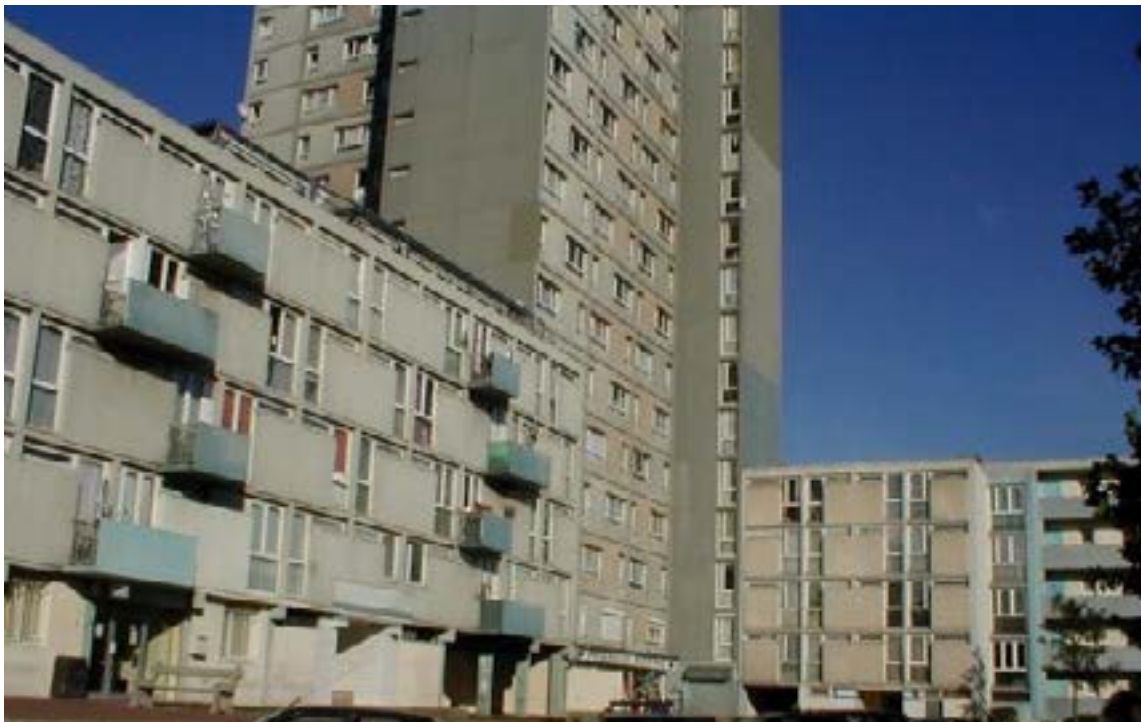
Fig. 54 : La Cité de l'étoile, Benoit Pouvreau pour l'Atlas de l'architecture et du patrimoine de la Seine Saint Denis, 2004
