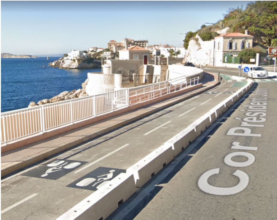
Figure n°10 : Photo une piste cyclable séparée de la voirie et sécurisée; Source : Google Maps; La Corniche; Marseille 7ème; 2021
