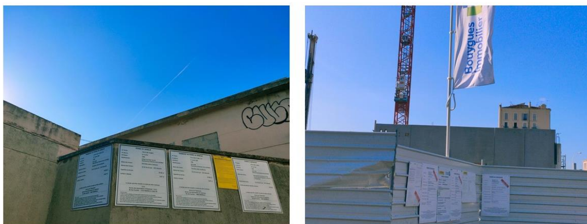
Figure 18 : Les chantiers de Smartseille 2 et des fabriques (© Photographies de l'auteur)
