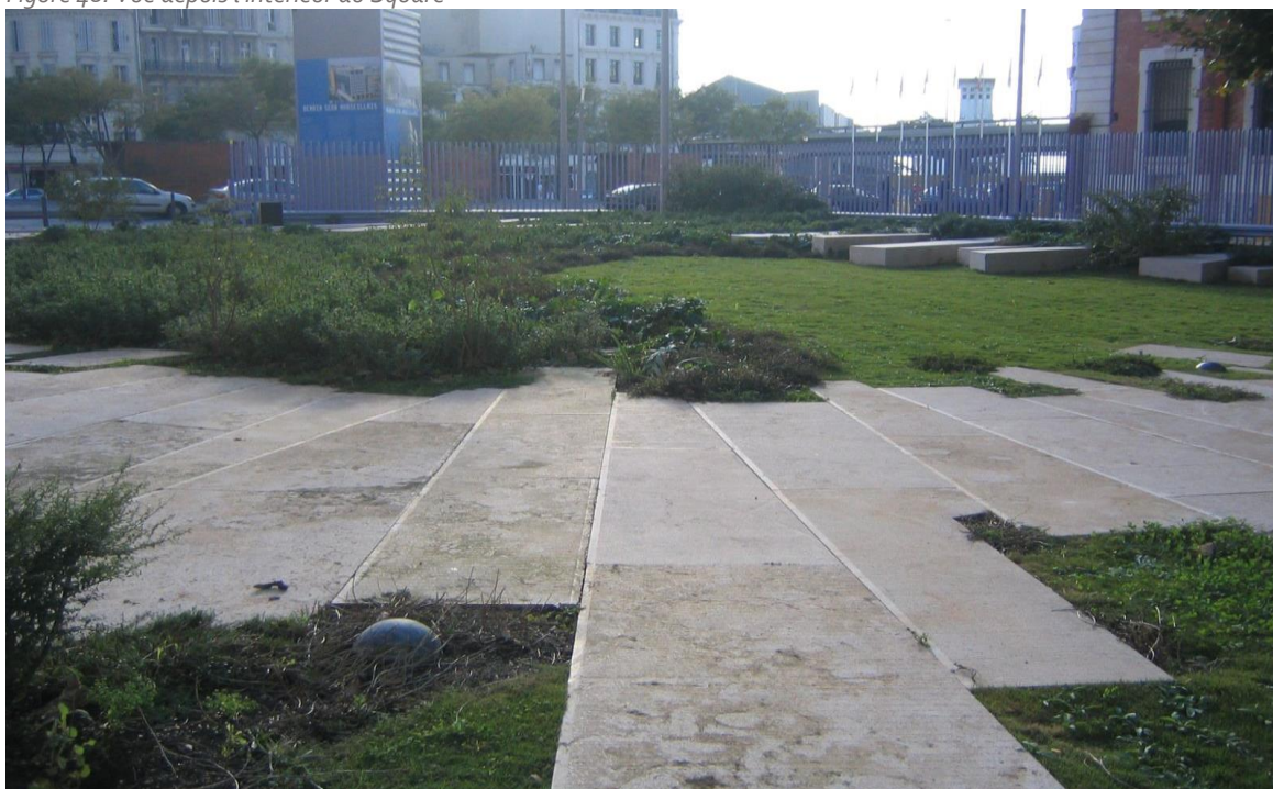
Figure 49 : Photo du square au moment de sa livraison R. Duthoit
