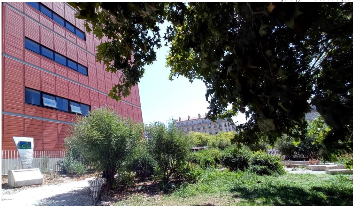
Figure 48: Vue depuis l'intérieur du Square
