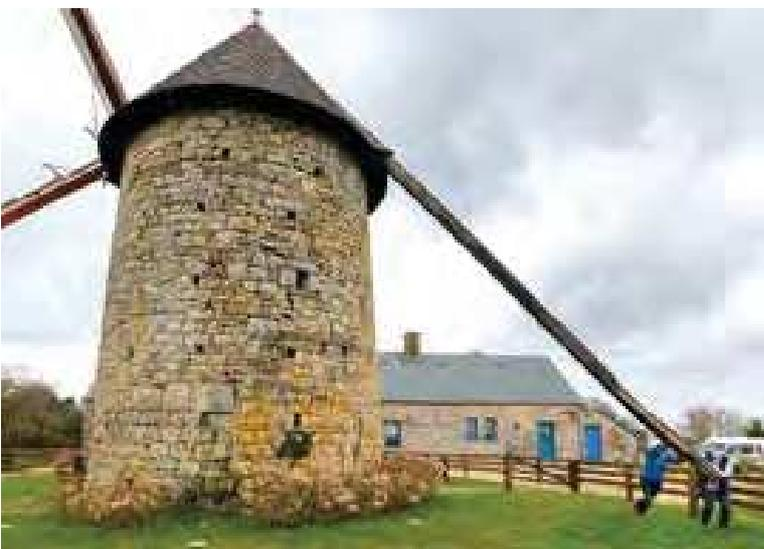
▼ Pour faire tourner le Moulin, des rafales de 50 à 70km/h sont nécessaires. Cela nécessite d'orienter les ailes en fonction du sens du vent. Une opération physique et quotidienne.
