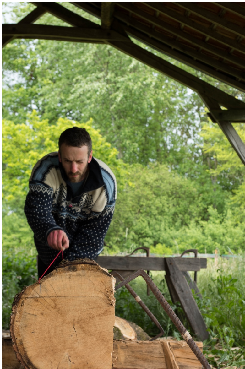
Figure 8 : Bille de chêne posée sur tréteaux et fixée par des clameaux. (Léonard trace au rouge la ligne de repère pour les entailles à réaliser sur la deuxième face.)
