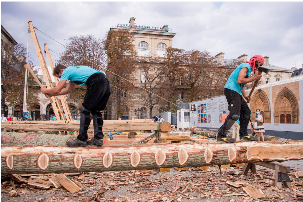
Figure 9 : Photographie d'une démonstration d'équarrissage sur le parvis de Notre-Dame par des charpentiers CsF.
