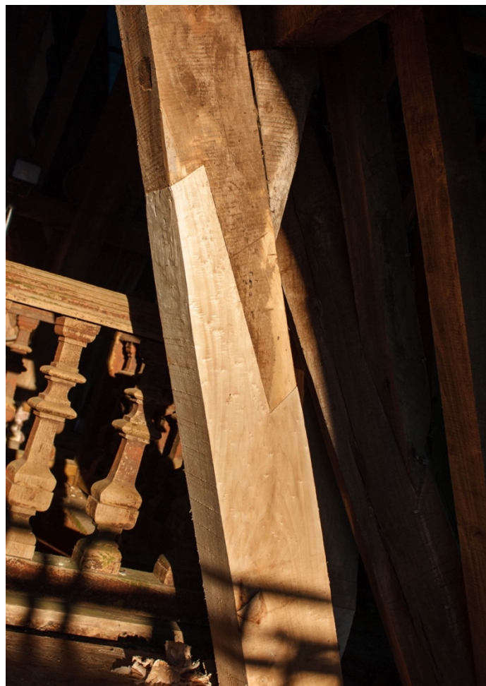
Figure 24 : Photographie d'une greffe en pied d'arbalétrier
