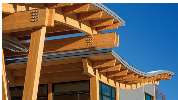
Figure 6 : Schéma et exemple d'une construction en lamellé-collé
