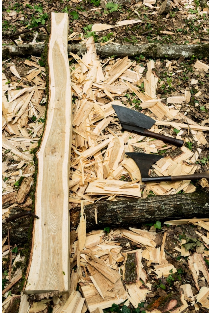
Figure 20 : Photographie de la colombe en cours d'équarrissage
