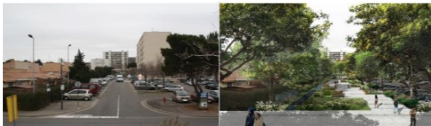
Figure 74 : Image actuelle de la rue des écoliers et image de projet de la rue jardin Source : Document de présentation du projet, juin 2018, groupement L'Adéus pour la Métropole AMP & Ville de Miramas
