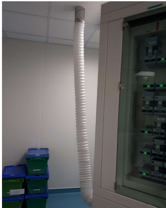
Figure 47 : L'automate a été équipé d'un système de ventilation relié directement à l'extérieur, pour limiter les poussières médicamenteuses dans la PUI.
