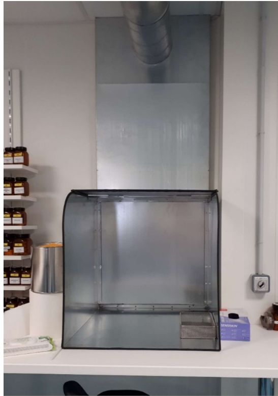
Figure 42 : Hotte dans la salle de l'automate (à Sainte-Marie), destinée au remplissage des cassettes à partir des pots contenant les spécialités déconditionnées.
