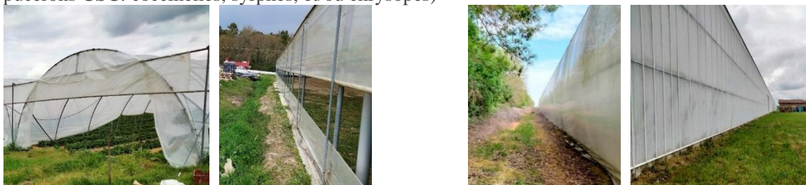
Figure 19 : Photos comparatives des ouvertures vers l'environnement pour les tunnels, les multichapelles ouvertes sur le toit et les côtés, les multichapelles ouvertes sur le toit uniquement et les serres verres (production personnelle).
