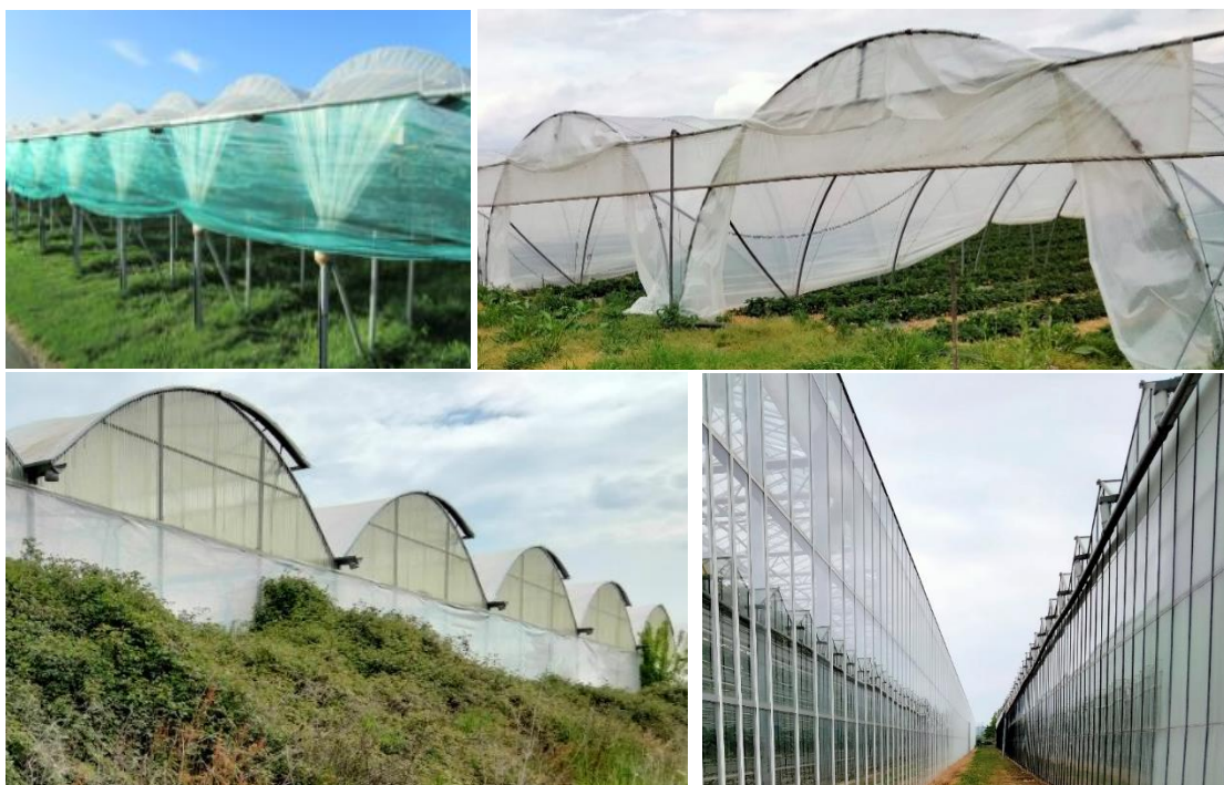
Figure 6 : Photos d'exemples des différents types d'abris hauts, dans l'ordre : chenilles basses (crédit photo : http://www.degrav-agri.fr/ ), tunnels, multichapelle, serres verres (productions personnelles)
