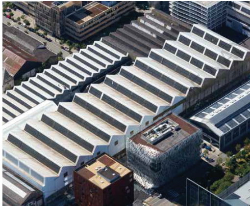
Photographie aérienne des Halles Alstom avant le début des travaux de reconstruction
