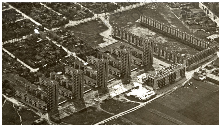
Vue aérienne de la Cité de la Muette à Drancy. Fonds Beaudouin et Lods
