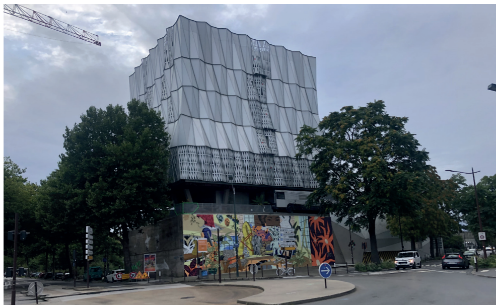
Juillet 2020, Façade du Trampoline, Île de Nantes
