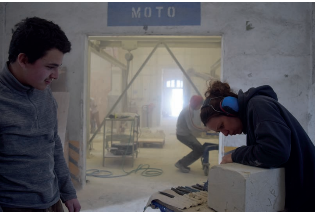
Ⓢ Lila essaie de faire un chanfrein sur cette roche de tuffeau, très friable, sous le regard attentif de Tourangeot en formation chez les Compagnons.
