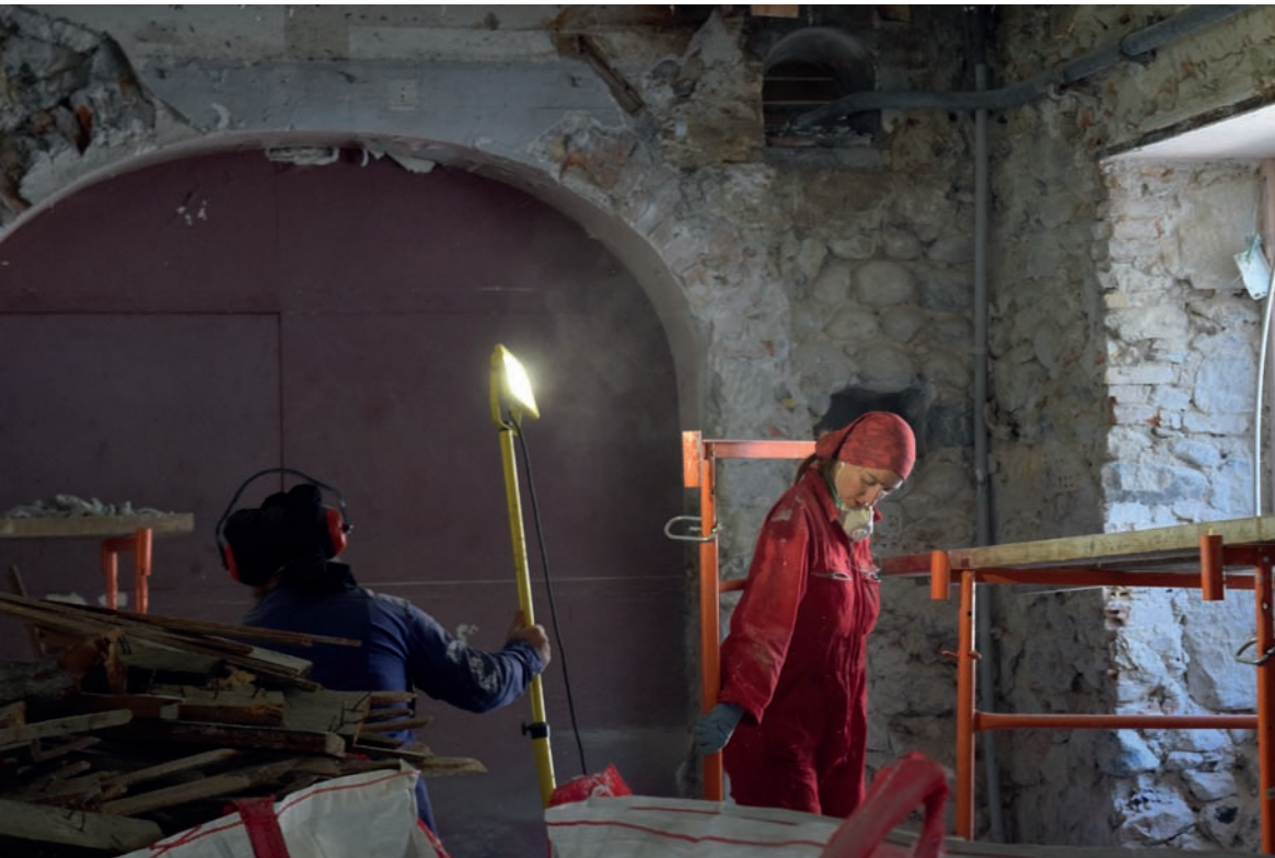
Ⓔ Chantier dans la future salle de spectacle, à Chirols.
