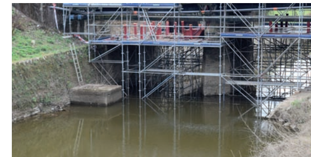
Ⓔ Echaffaudage autour d'un pont, sur le Hâvre. Oudon, le 16 mars 2021
