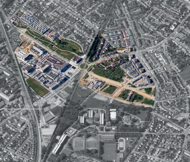
Fig. 56 : L'écoquartier Bottière Chénaie en pleine construction. Source : AmazingNantes.
