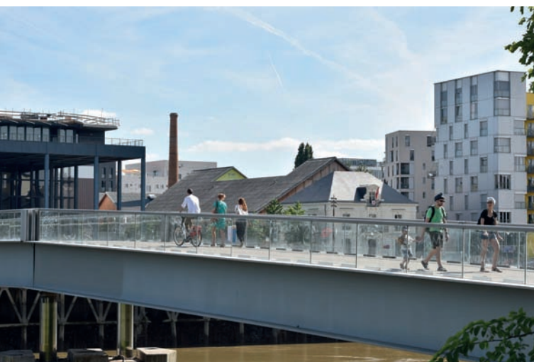
Fig. 20 : La passerelle Victor Schoelcher, montée sur des vérins pour s'adapter aux marées et au passage des bateaux. Source : Jean-Dominique Billaud/Samoa.
