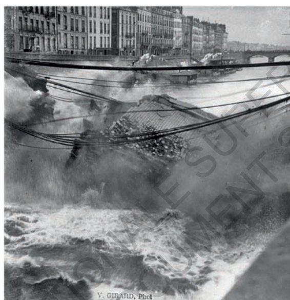
Fig. 9 : L'effondrement du pont Maudit, 16 juillet 1913. Source : Archives Municipales de Nantes 26fi 1098
