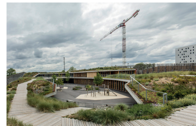
Fig. 59 : L'enceinte créée autour de l'école Aimée Césaire par la toiture végétale innovante. Source : CAUE.
