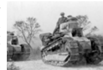
Il s'agit là de deux réalisations pionnières dans l'usage du béton armé, qui en est encore à l'expérimentation.
