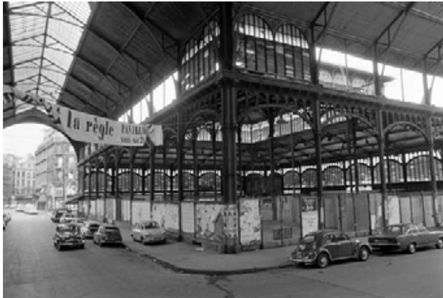
24. Les Halles de Paris, avant leur destruction en 1971.
