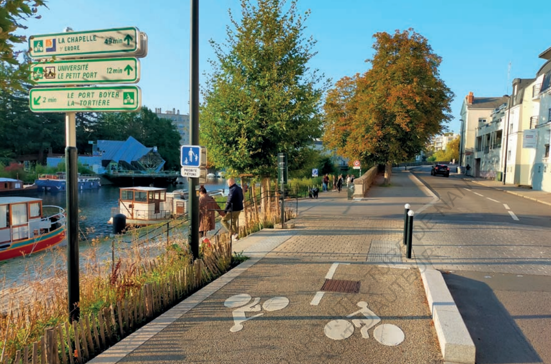
Ci-dessus : axe vélo nord-sud ; Ci-dessous : axe vélo est-ouest. Ces réalisations de 2019 démontrent la grande difficulté à assurer la continuité stricte des pistes cyclables, qui finissent bien souvent par mélanger les cyclistes avec les piétons ou le trafic motorisé aux intersections.
