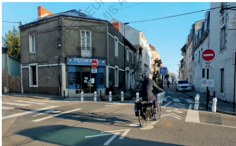
Filtre modal à l'intersection de la rue d'Allonville avec la rue de Coulmiers
