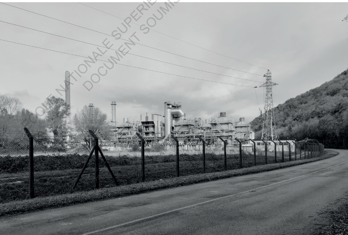
11h11 - Centrale thermique
