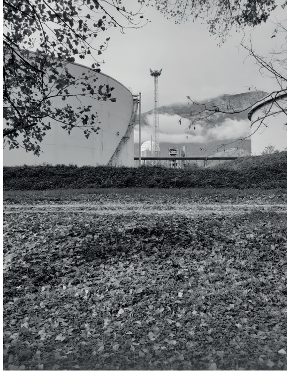
10h51 - Stockage de Soude
