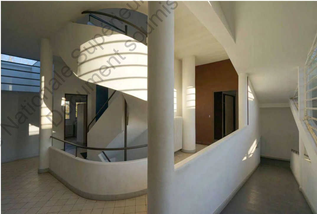
Fig. 54 L'escalier en colimaçon inséré dans la vision horizontale.
