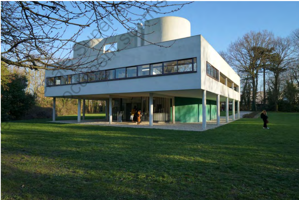
Fig40. Façade nord de Villa Savoye Sources: photo personnelle
