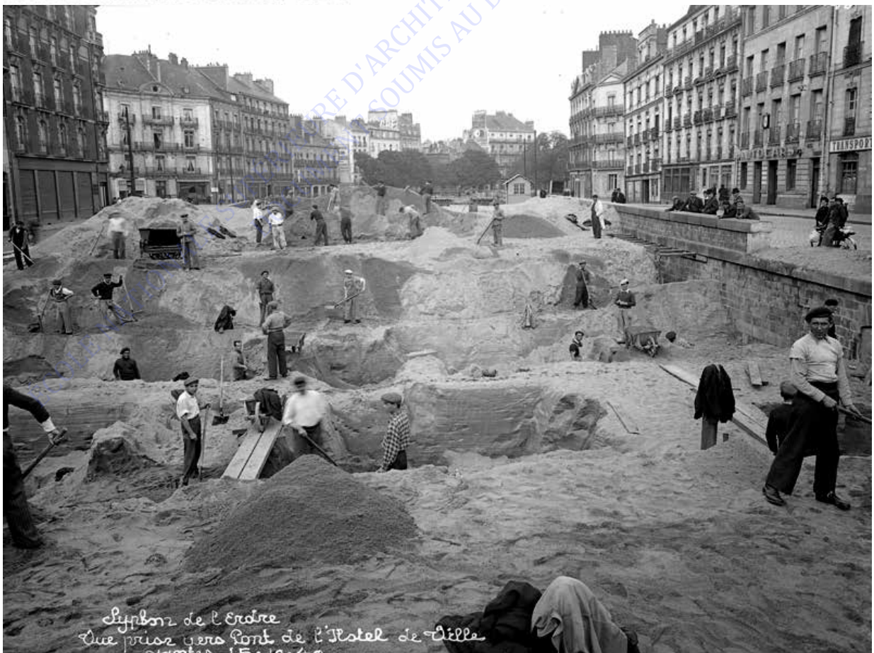
Comblement de l'Erdre : travaux du siphon de l'Erdre - 15/10/1940 © Archives municipales de Nantes
