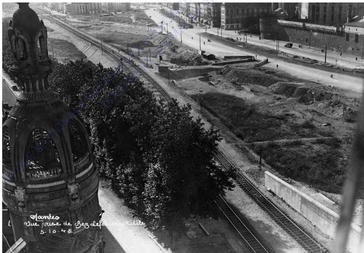
Aménagement des espaces comblés entre la gare d'Orléans et l'île Feydeau 1942 © Archives municipales de Nantes, 25Fi4716
