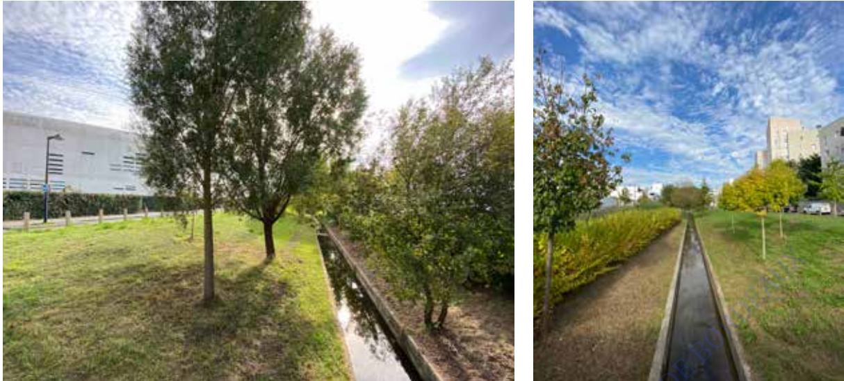
Noue centrale linéaire dans une cunette en béton
