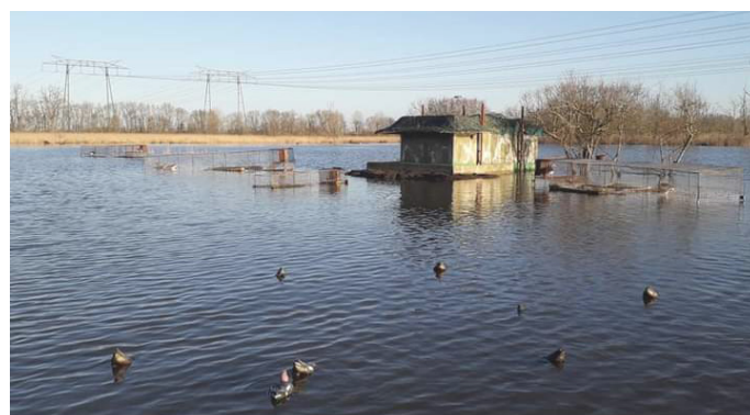
Les travaux autour de l'installation
