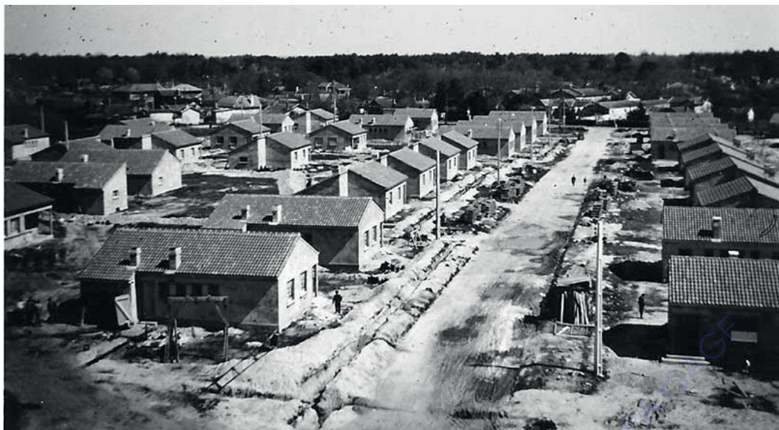
Photographie. Pendant le chantier, en 1950. © Association culturelle des Castors de Pessac
