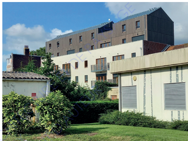
Vue discrète sur la façade intérieure de la « Coop' à Fourchon »
