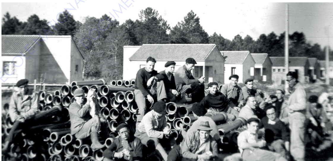
Photographie. Pendant le chantier, en 1950. © Association culturelle des Castors de Pessac
