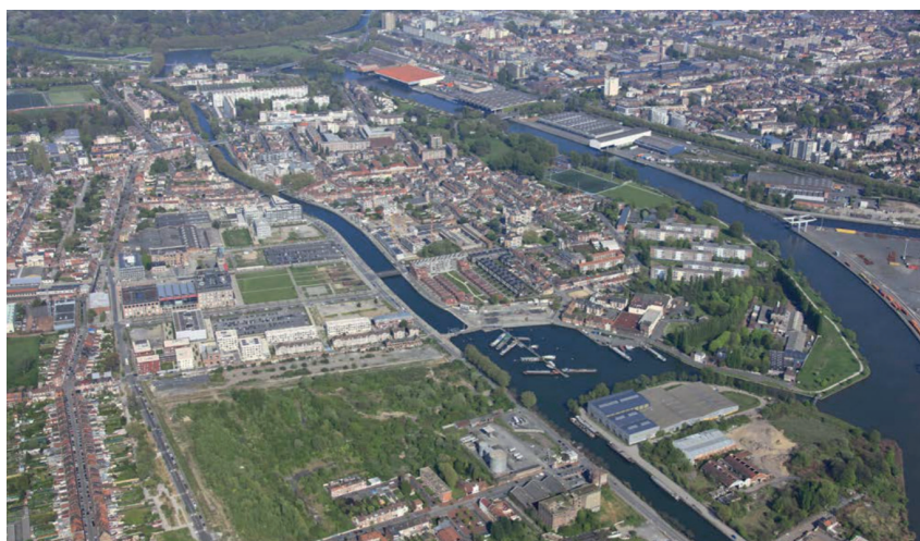
Vue aérienne oblique du quartier de Bois-Blancs à Lille. Bocquet.
