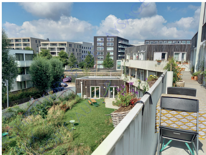
Photographie prise depuis la coursive R+2
