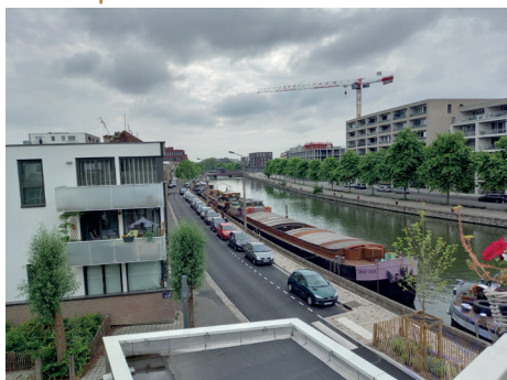
Vue depuis la coursive du 2ème
