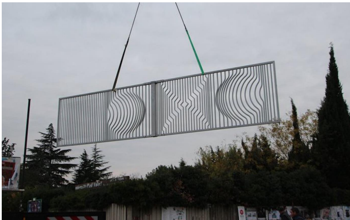
Figure n°34 : Déplacement du Portail Vasarely en 2018
