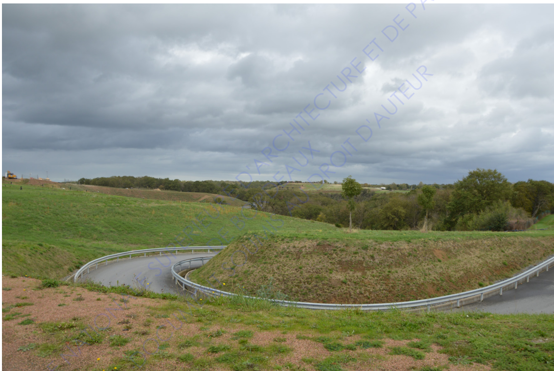
Exploitation du centre d'enfouissement au lieu-dit de « Villeneuve », au loin l'ancien site désormais fermé, Maillet, 2019. PP.
