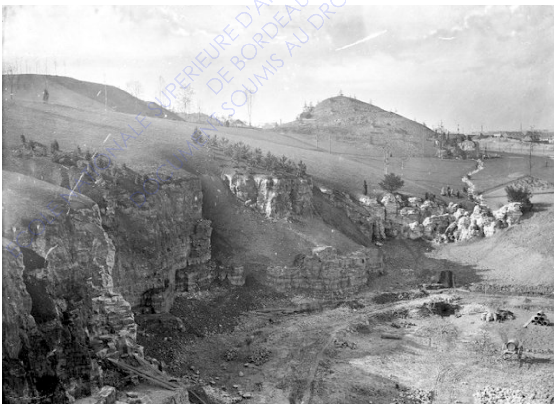
13. Le parc des Buttes Chaumont en cours de transformation en 1866. Au départ exploiter en tant que carrière, le site sera plus tard utilisé comme décharge public parmi d'autres usages mis à la marge. Sa transformation est une prouesse d'ingénierie comme peuvent aujourd'hui l'être les parcs aujourd'hui réhabilités.
