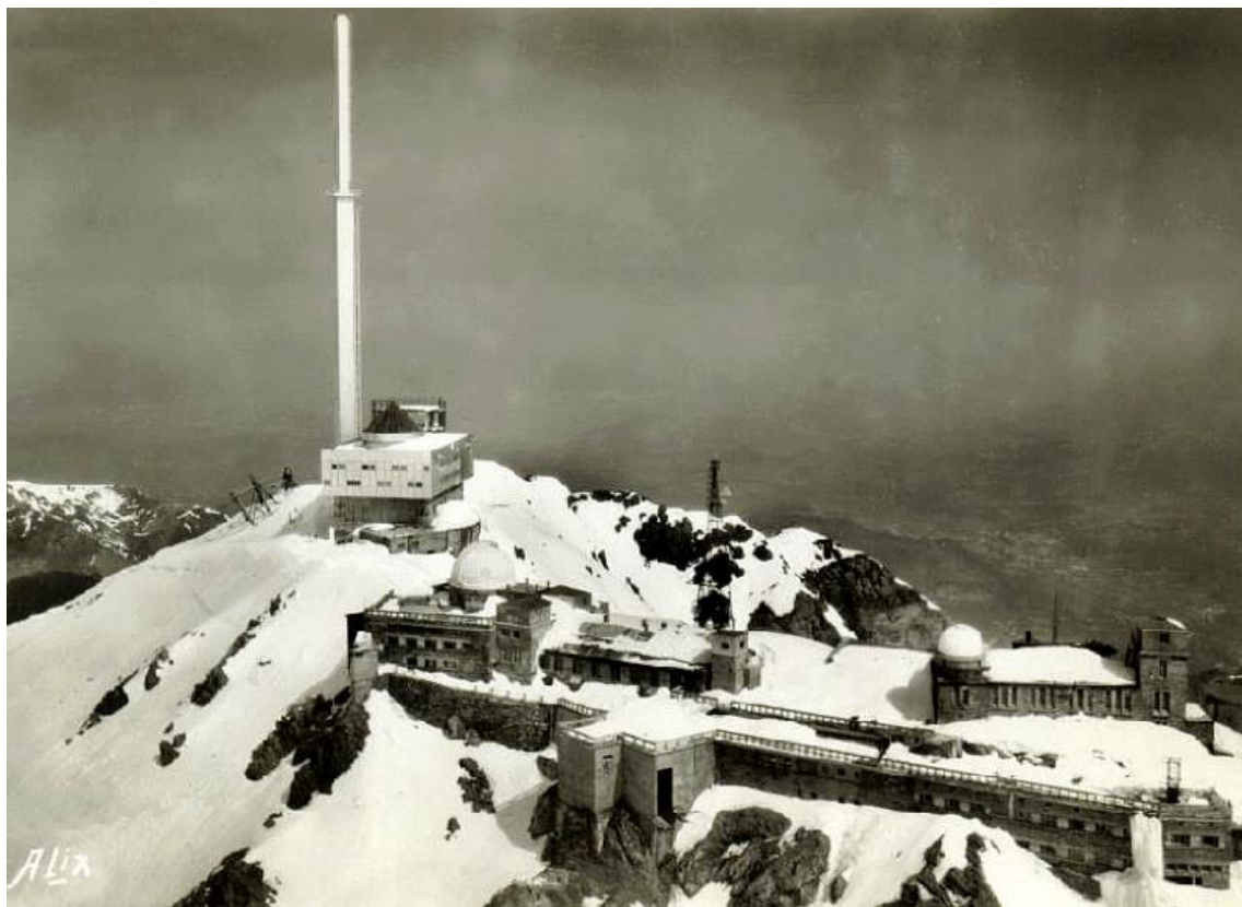
FIGURE 7 : LE PIC DU MIDI CHANGE DEFINITIVEMENT DE VISAGE AVEC L'INSTALLATION DE L'ANTENNE DE 103 METRES ET DU BATIMENT INTERMINISTERIEL (1963). © ALIX, FOND EYSSALET
