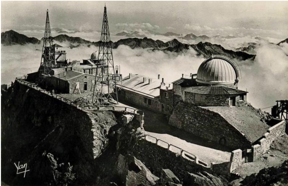
FIGURE 5 : L'OBSERVATOIRE DU PIC DU MIDI EN 1948. A GAUCHE, EXTENSION DU BATIMENT DAUZERE ET L'INSTALLATION DE LA COUPOLE GENTILI. © YAN, FOND EYSSALET
