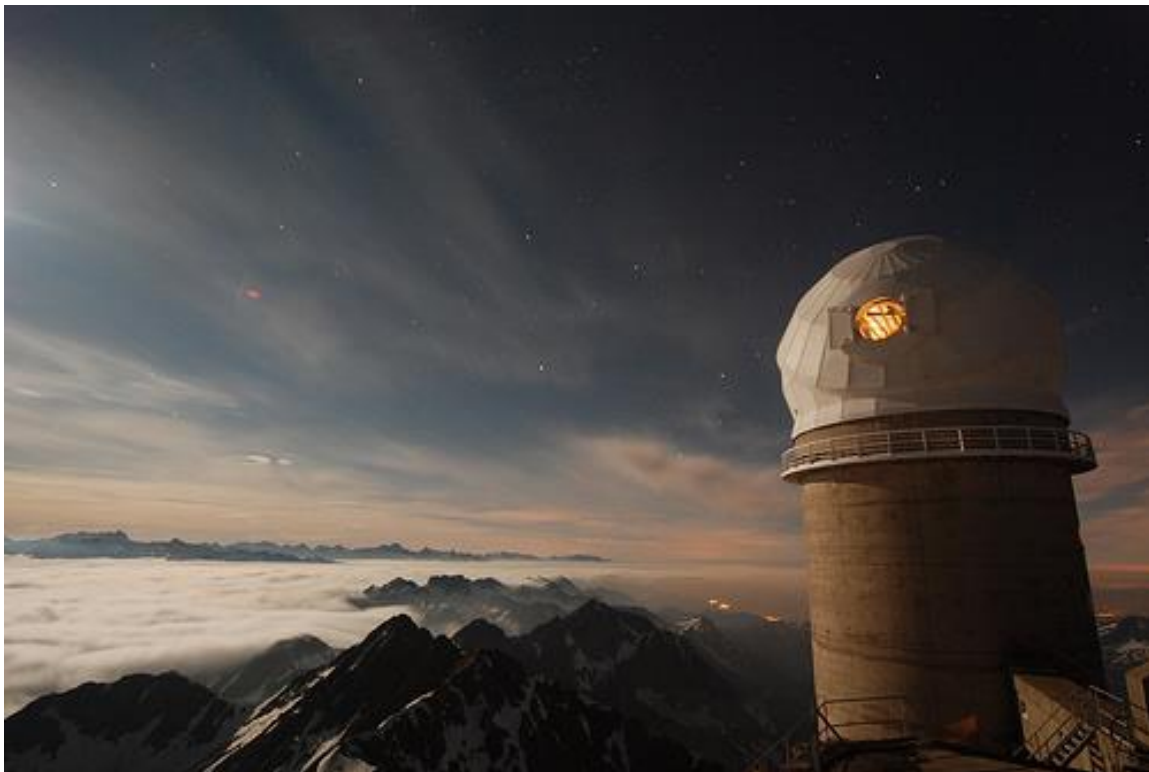
FIGURE 11 : LA TOUR ET LA COUPOLE DU TELESCOPE BERNARD LYOT AU SUD-OUEST DU SOMMET. L'OPERCULE EST OUVERT A L'EST. © REGIE DU PIC DU MIDI
