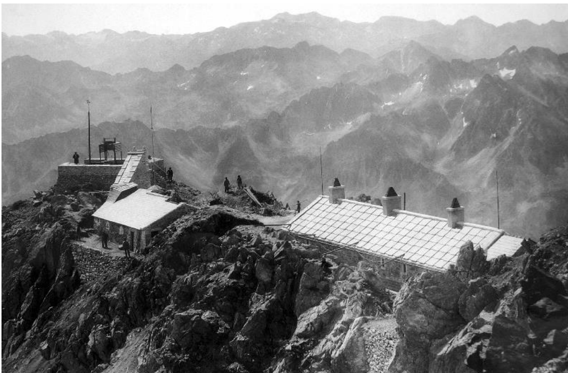
FIGURE 3 : L'OBSERVATOIRE DU PIC DU MIDI EN 1891. DE GAUCHE A DROITE, LE BLOCKHAUS, LE BATIMENT VAUSSENAT ET LE BATIMENT NANSSOUTY. LA TERRASSE N'EST PAS ENCORE AMENAGEE. © REGIE DU PIC DU MIDI ET OBSERVATOIRE MIDI PYRENEES
