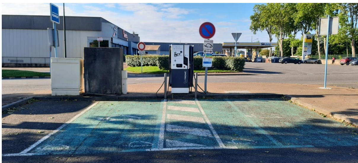
Photographie 14 - Bornes de recharge pour voitures électriques à la gare routière de Lavour
