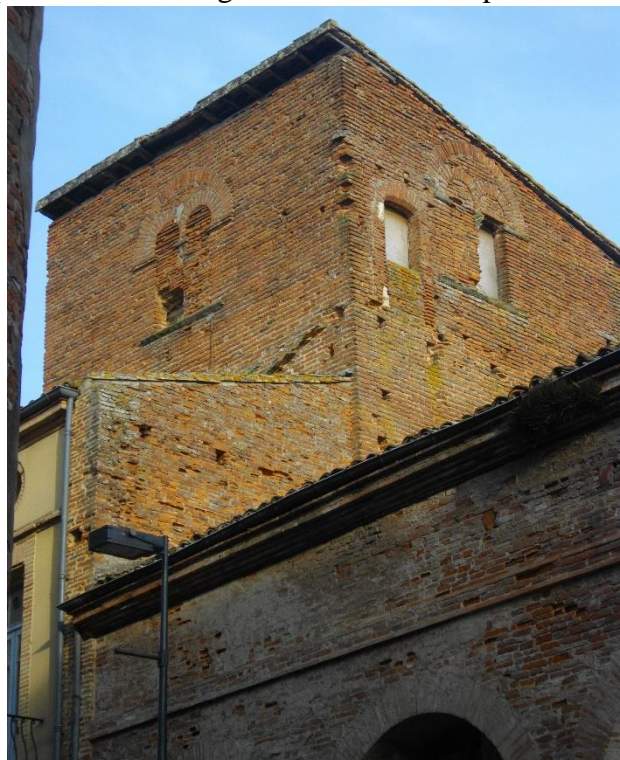
Figure 12 : La Tour Palmata à Gaillac (Source : Wikipédia)
