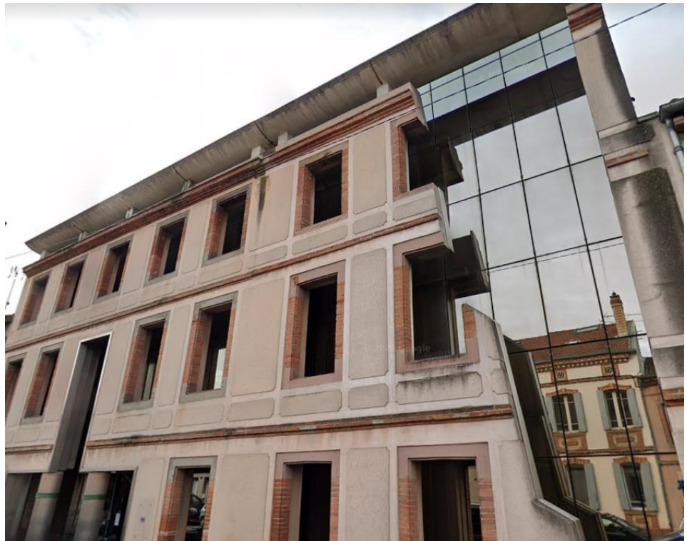
Figure 14 : Exemple de façadisme à Albi (Source : Inès Astié)
