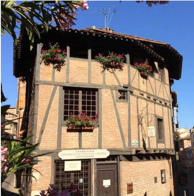
Figure 8 : Maison albigeoise typique se présentant comme l'une des plus anciennes de la ville. (Source : Mairie d'Albi)
